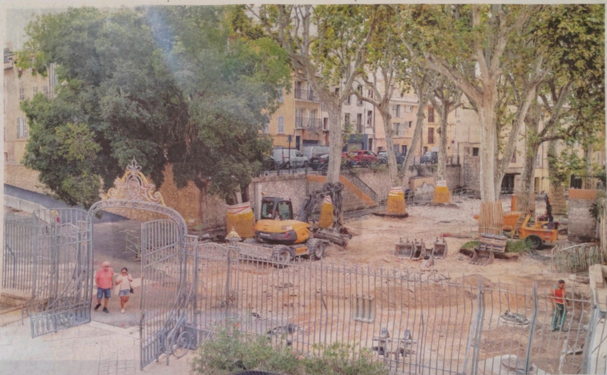
La première phase des travaux concerne l'aménagement du jardin des thermes, en haut du cours Sextius. / PHOTO CYRIL SOLLIER
